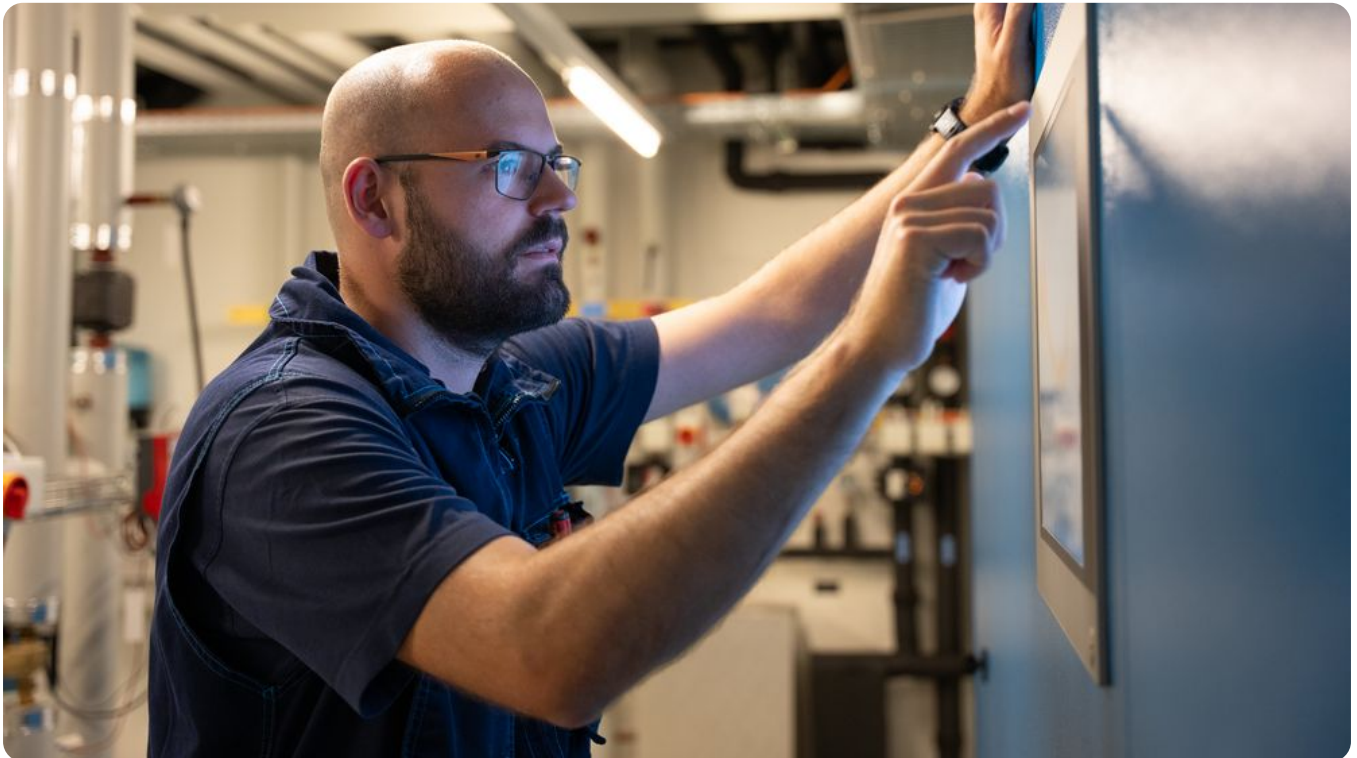
Matthias Jaggi kontrolliert 2x jährlich die Batterieleistung der Notbeleuchtung.
